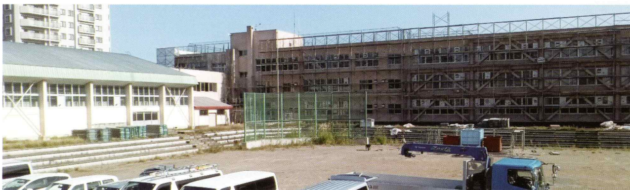
令和5年8月22日撮影 建物内の解体を終え、建物解体前です。
