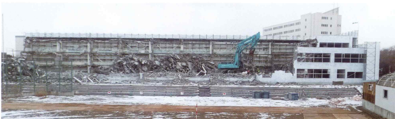
令和5年11月30日撮影 体育館の解体を終え校舎本体の解体中です。
